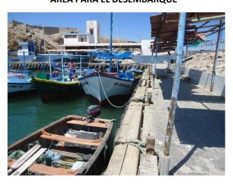
Muelle espigón en malas condiciones, sin cabezo y techado para la protección del producto desembarcado. Su condición genera peligro para los mismos pescadores que ingresan al muelle.
